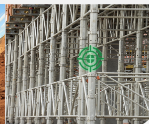
高支模倾斜测控
