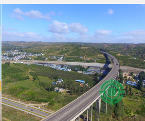
桥梁结构健康监测
