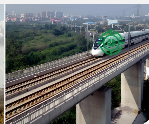
桥梁结构健康监测
