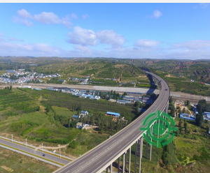
桥梁结构健康监测
