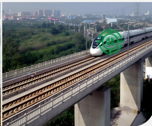
桥梁结构健康监测
