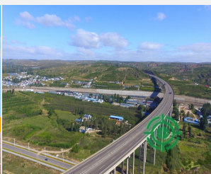
桥梁结构健康监测
