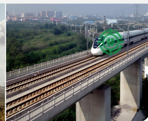
桥梁结构健康监测
