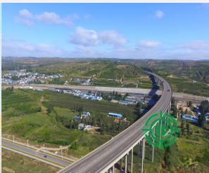
桥梁结构健康监测
