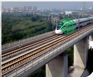
桥梁结构健康监测
