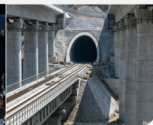
高铁线下工程监测
