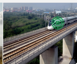
桥梁结构健康监测
