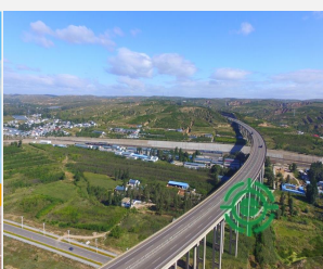
桥梁结构健康监测
