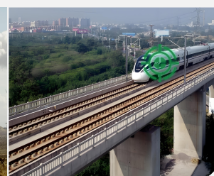
桥梁结构健康监测
